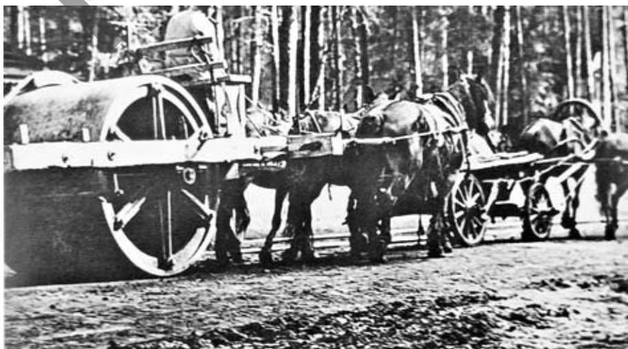
● Уплотнение поверхности дороги конным катком, 1930-е.
